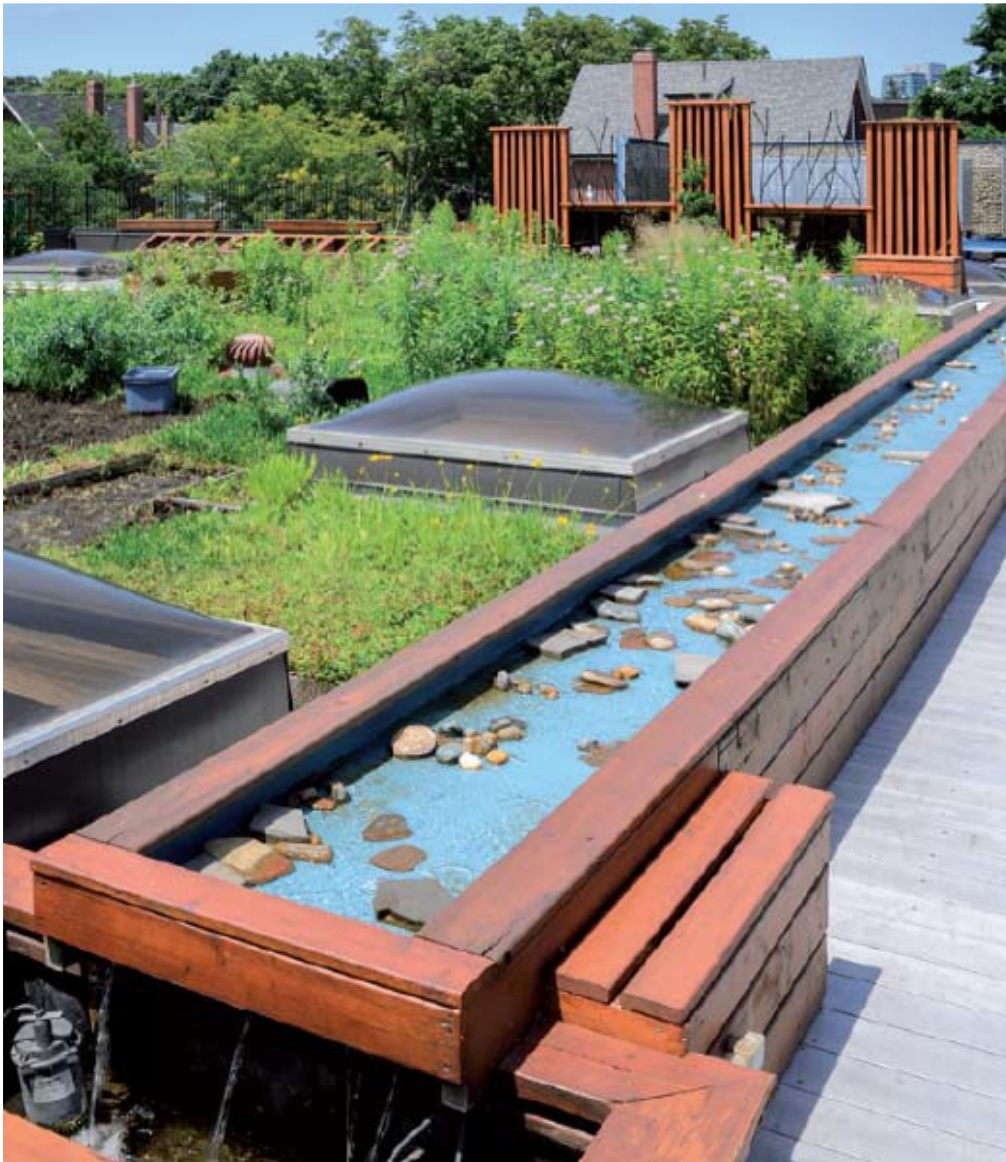
Esempio di tetto verde piano.
