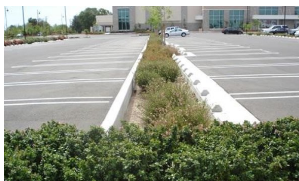
Esempio di fosso vegetato in California (USA) tratto dal "Manuale di drenaggio urbano" (Regione Lombardia, ERSAF, Gibelli, 2015)
