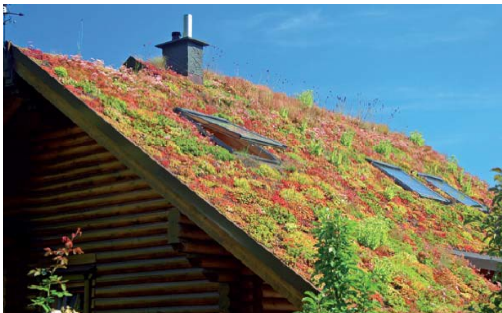
Tetto verde in falda.
